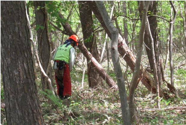
2026/5 に実施した保安林の枯死木・倒木処理作業
